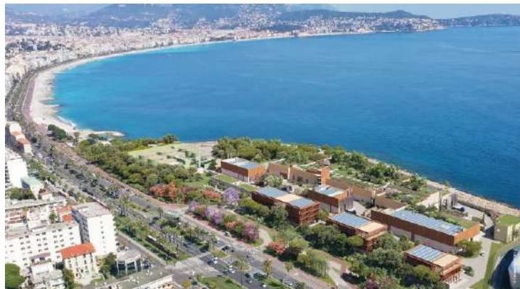
Figure 125 : Vue du bâtiment tertiaire qui accueillera les services techniques de Eau d'Azur et l'ODD (hors projet)
