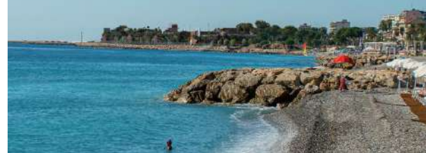
Figure 123 : Bâtiment process (vue depuis les plages)
