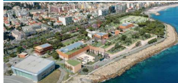
Figure 124 : Bâtiment process (vue depuis les airs)
