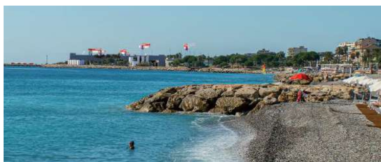
Figure 172 : Vue du chantier depuis les plages
